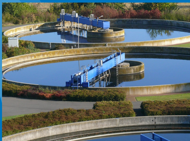
Foto © Eberhard Städtler Kläranlage Euskirchen1.jpg
