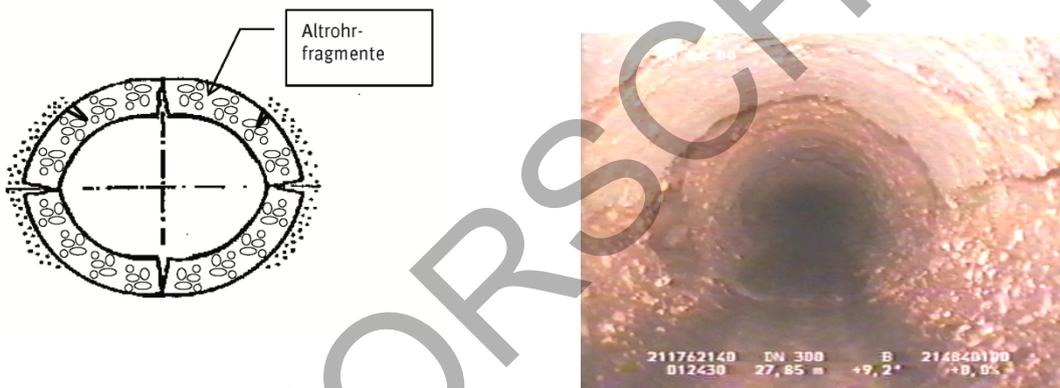
Bild K.1: Altrohrzustand IIIa (erhebliche Scherbenbildung, Betongüte z. B.  $\leq C8/10$ , aus Bohrkernen ermittelt, Mauerwerksfestigkeit II oder schlechter und/oder ungünstige Bodenparameter)
