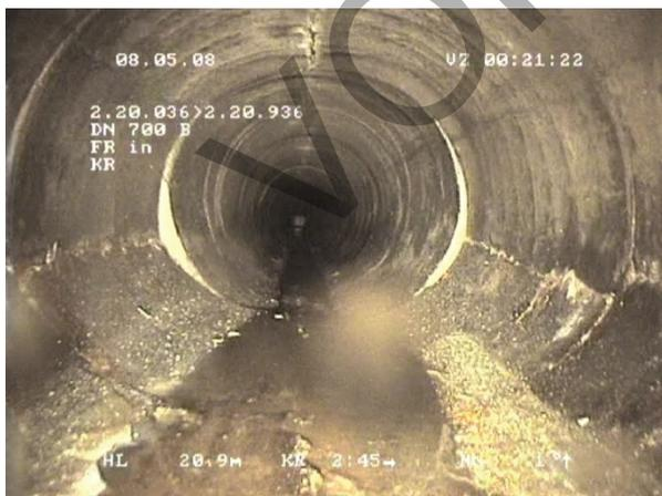
**Bild 12: Verformter Kanalquerschnitt (Scheitelriss klaffend, Kämpferisse innen geschlossen)**
