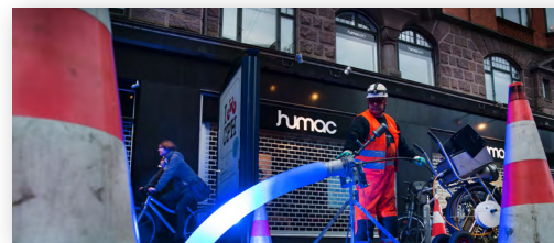
© Ines Knaack/Aarsleff Rohrsanierung GmbH
