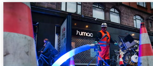
© Ines Knaack/Aarsleff Rohrsanierung GmbH
