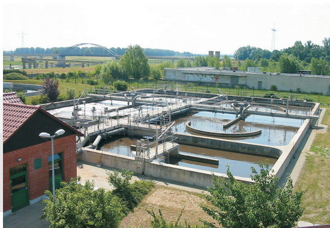
Kläranlage Torgau, Foto: DWA-LV S/T
