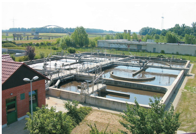
Kläranlage Torgau, Foto: DWA-LV S/T
